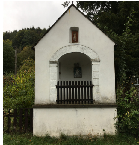
Kaplička před rekonstrukcí
