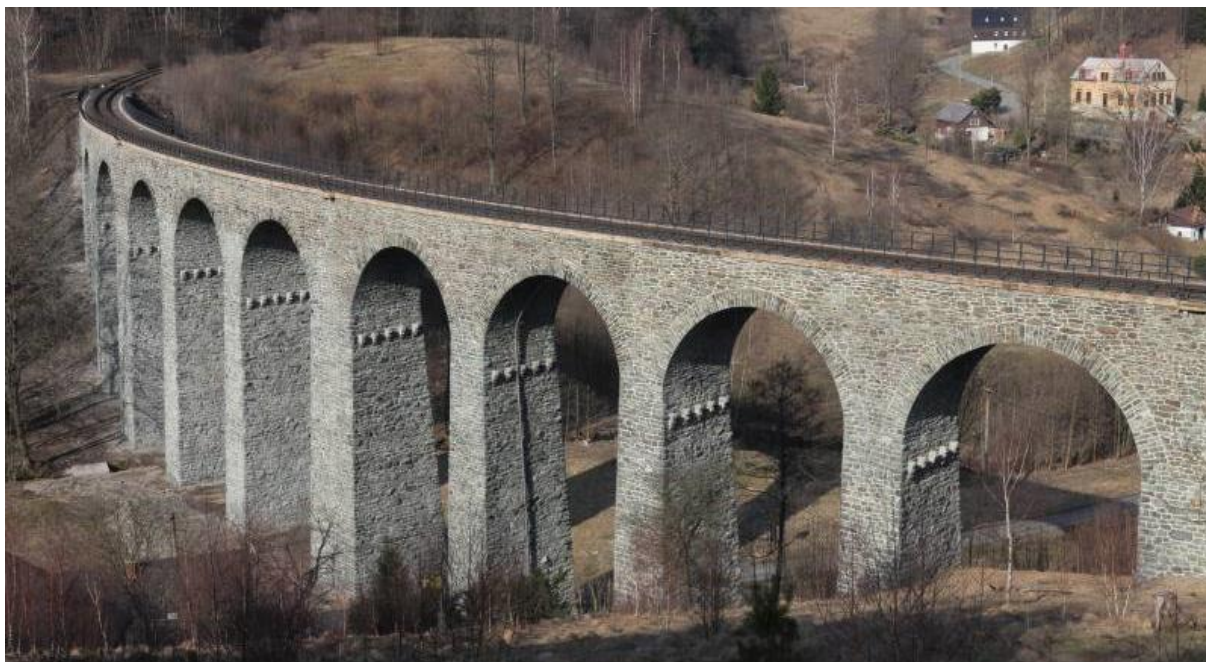
Obrázek 14 Železniční viadukt Novina
