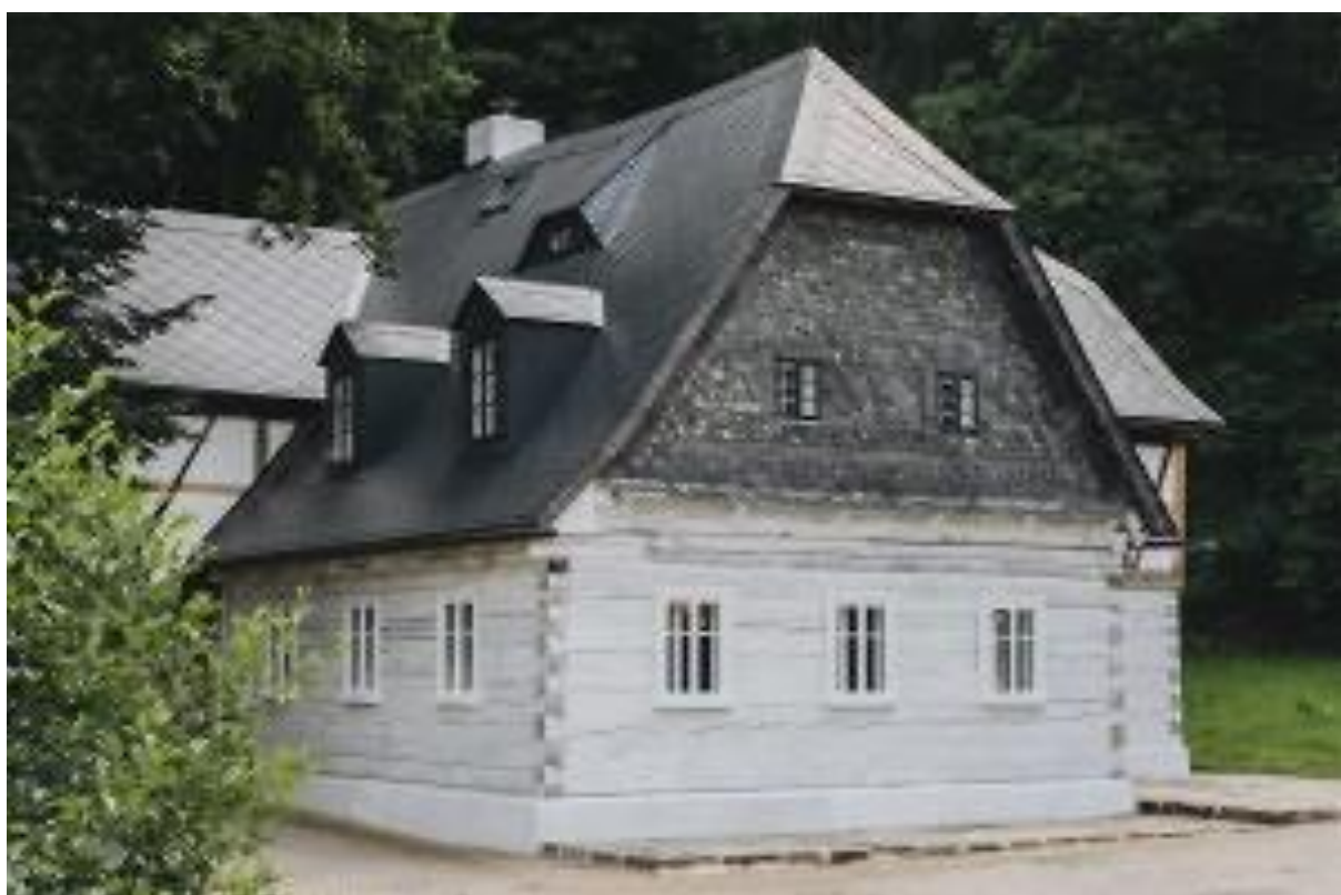
Obrázek 10 Dům č. p. 17 v Kryštofovo Údolí
