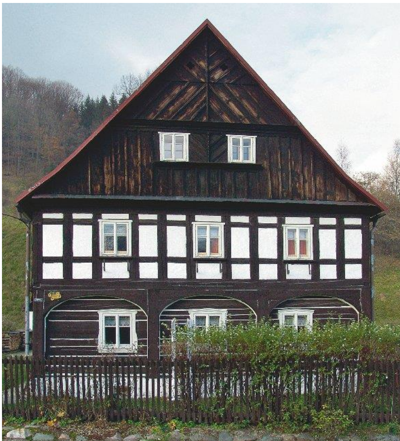
Obrázek 18 Dům č. p. 64 v Kryštofovo Údolí
