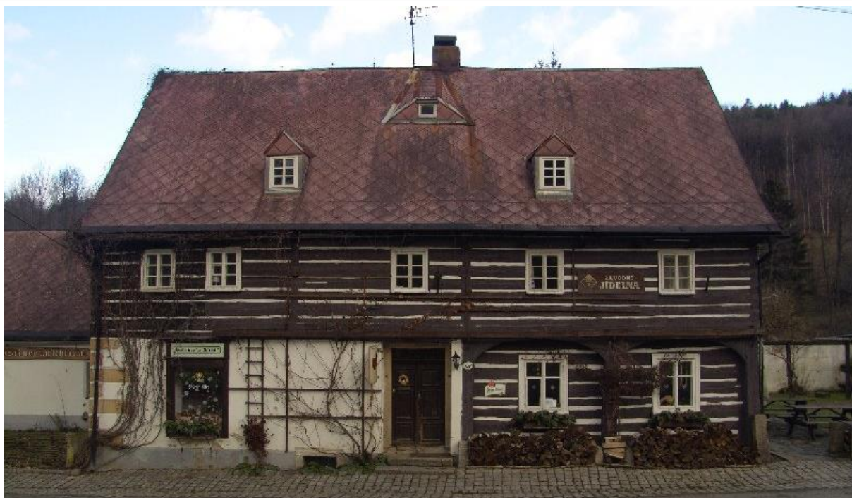
Obrázek 15 Dům č. p. 126 v Kryštofovo Údolí
