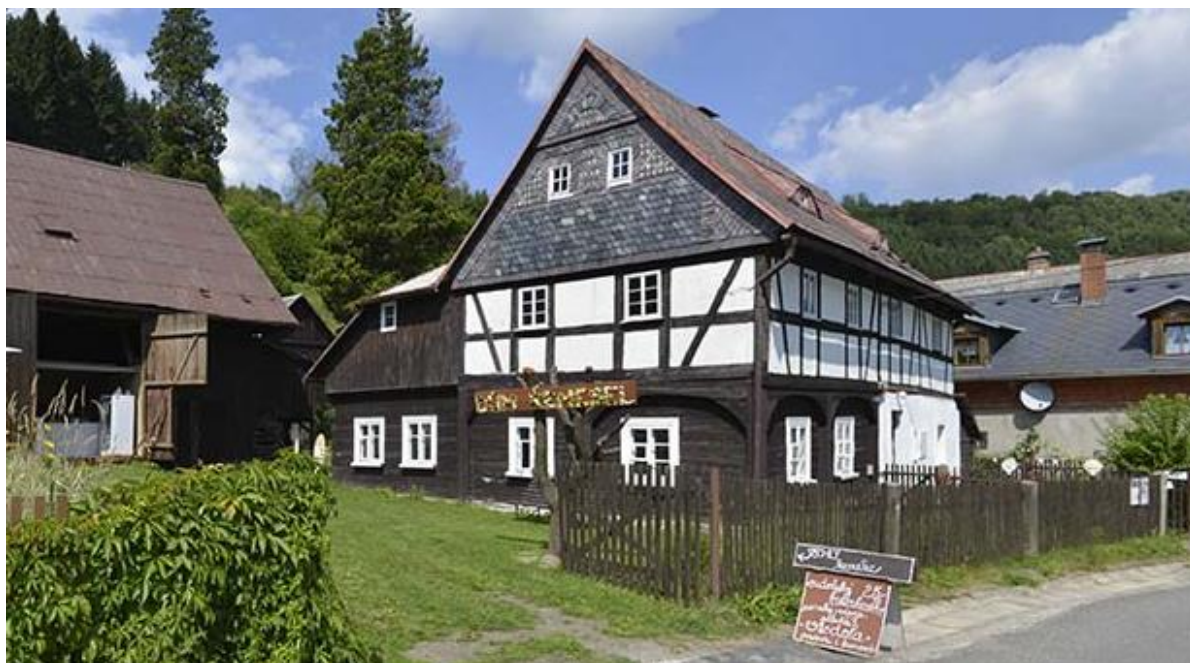
Obrázek 7 Dům č. p. 75 v Kryštofovo Údolí
