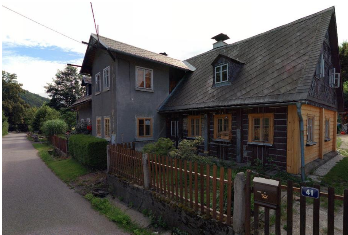
Obrázek 8 Dům č. p. 41 v Kryštofovo Údolí
