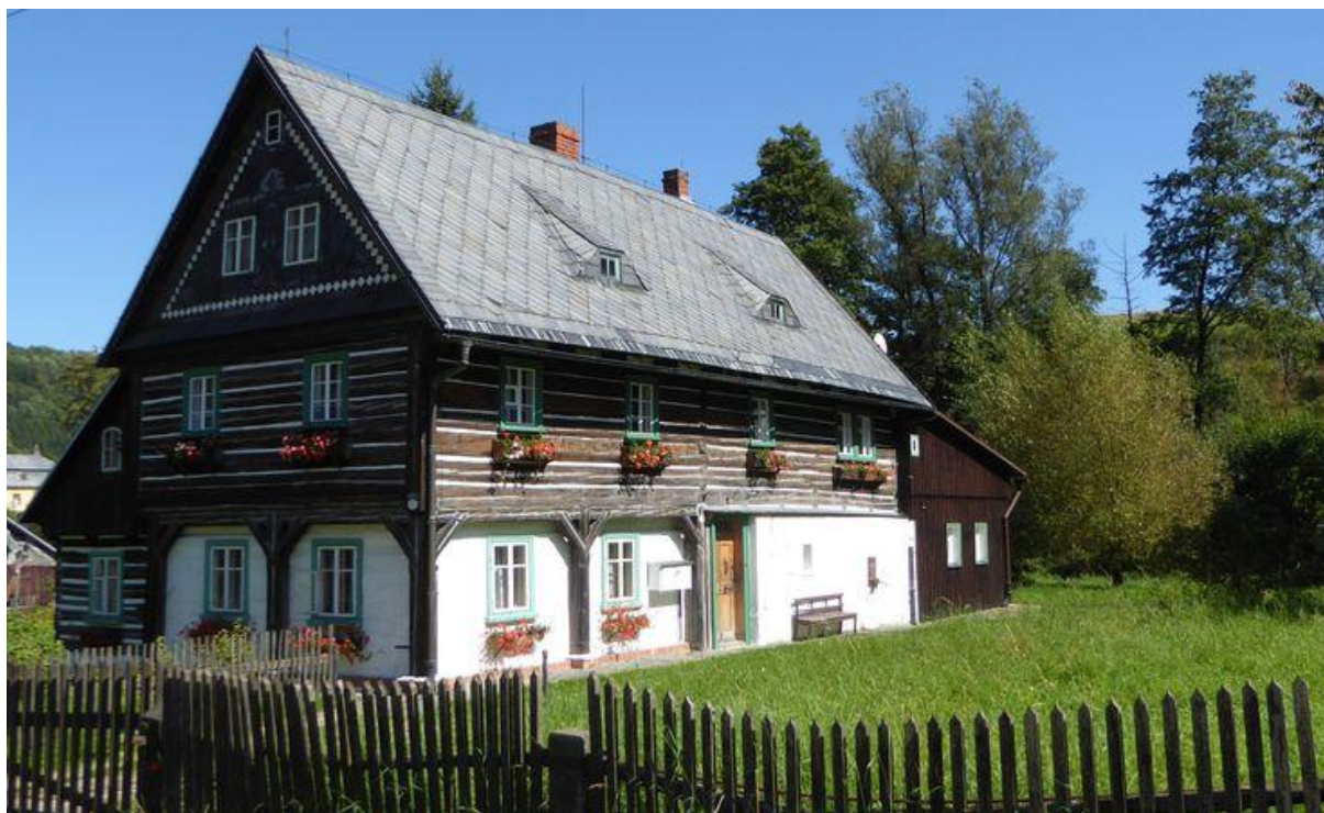
Obrázek 20 Dům č. p. 21 v Kryštofovo Údolí
