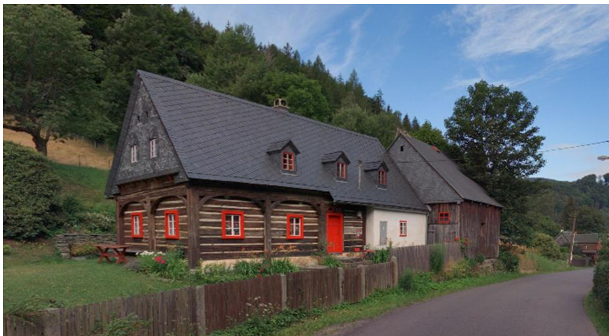
Obrázek 17 Dům č. p. 101 v Kryštofovo Údolí
