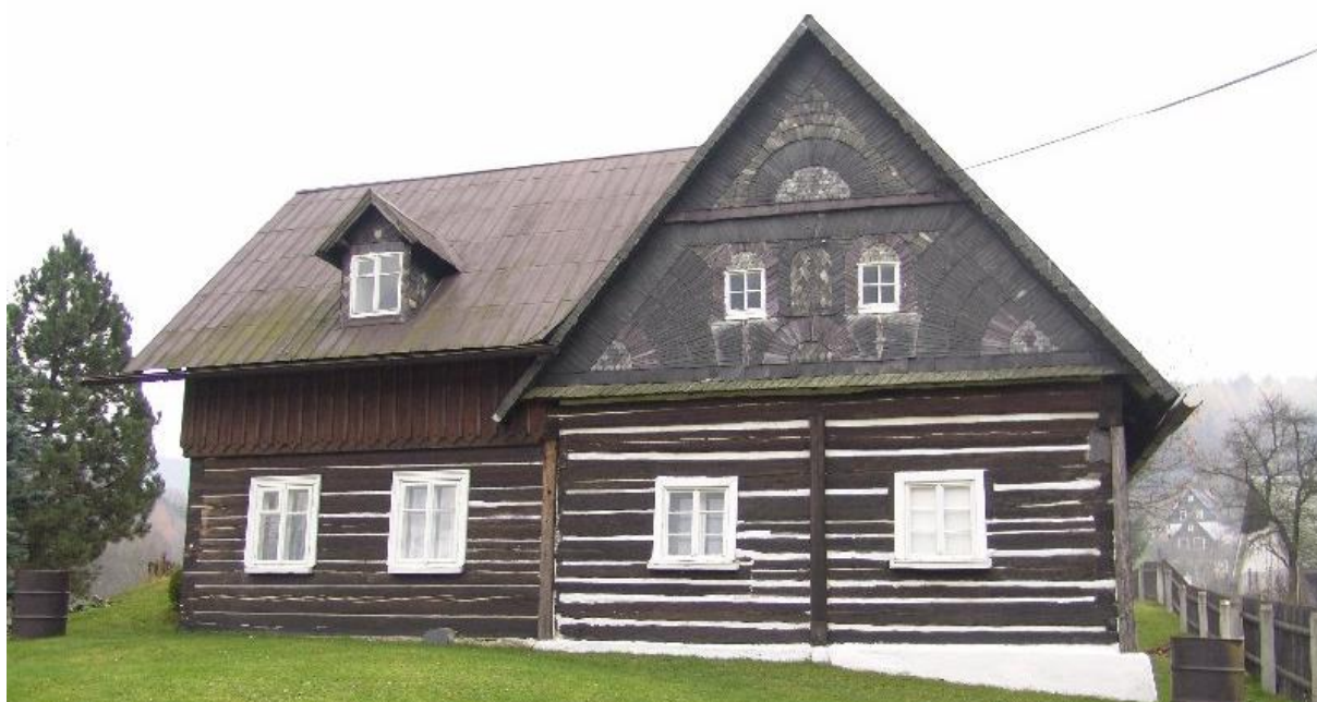
Obrázek 13 Dům č. p. 82 v Kryštofovo Údolí
