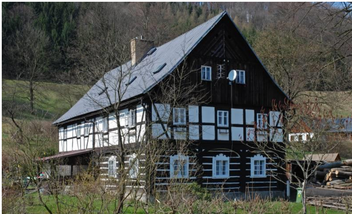
Obrázek 19 Dům č. p. 67 v Kryštofovo Údolí
