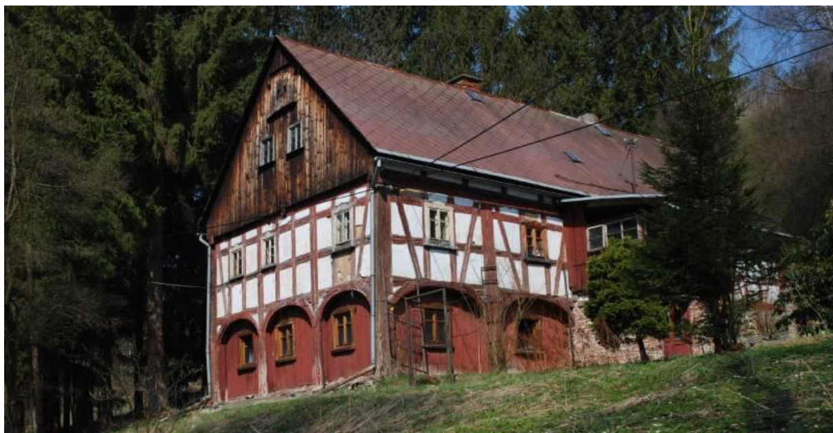
Obrázek 12 Dům č. p. 15 v Kryštofovo Údolí
