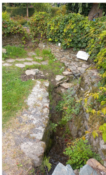
Foto: Studánka u Lacinů (stav před a po rekonstrukci)
